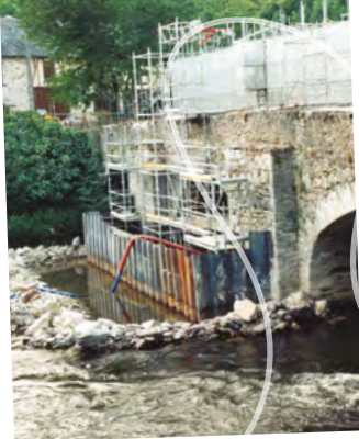
n°37 Restauration des piles
