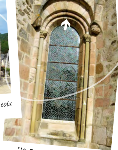
n°10 Baie surmontée d'un boudin limousin
