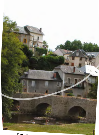
n°38 Vue sur le vieux pont et son quartier
