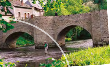
n°36 Le vieux pont vu de l'amont
