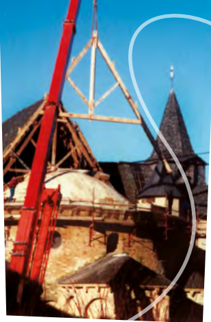
n°7 Restauration de la charpente
